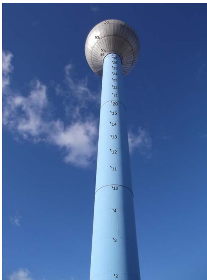
Obr. 3 Spoje sekcí a prstenců sloupu vodojemu
